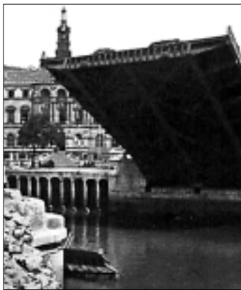
Reconstrucción del puente después de la Guerra
