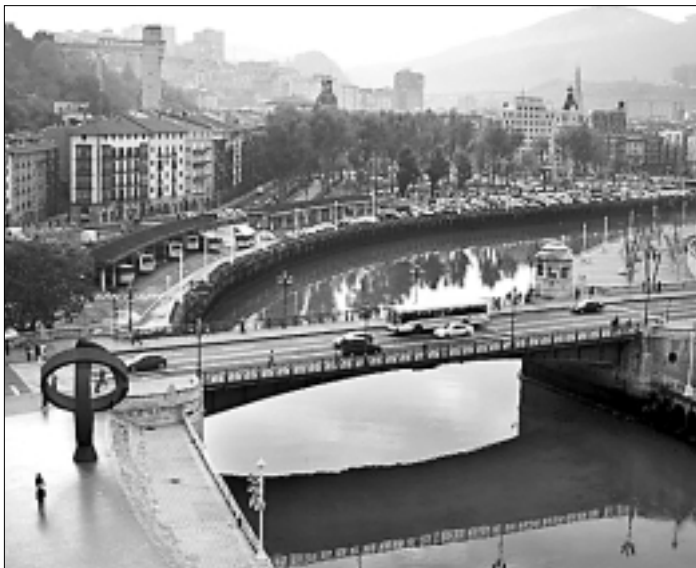
Vista actual del puente. Foto M. J. Cava
