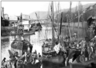
El puente del perro chico recién construido, 1892. F. Errazquin
