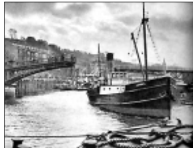
El puente, abierto
